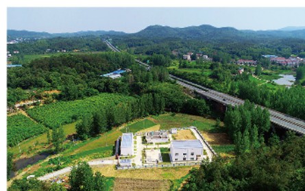
光圈下的洛阳镇污水处理厂 (马宜 管网事业部)
