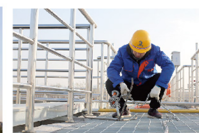
建设中的泗水厂 (刘干 水务运营事业部·山东)
